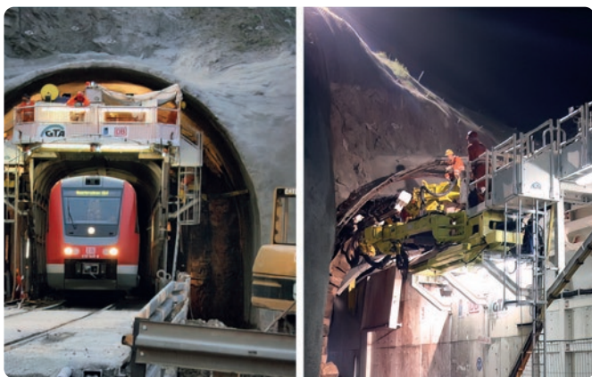
Für die Tunnelerneuerung wird die „Tunnel-im-Tunnel“-Methode angewendet.
